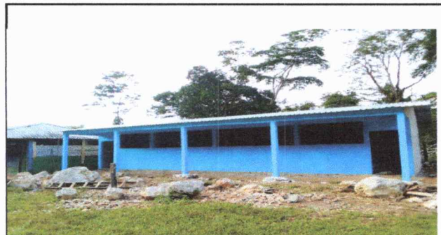
ESPACIOS DE CORREDOR
