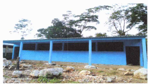
Foto 4: CULMINACION DE LAS INTALACIONES DE LAMINAS
