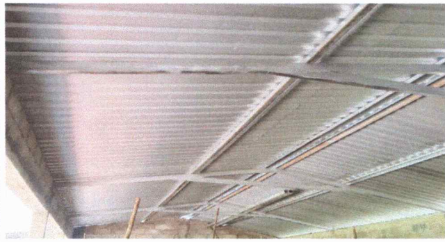
Foto1: INSTALACION DE COSTARA METALICA
